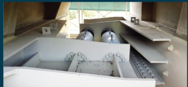
高鐵里程TK312橋梁改善工程
